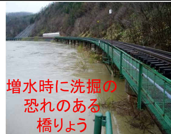
(例: 宗谷線 糠南・雄信内間 問平陸橋)
