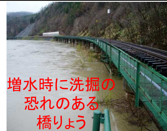
(例: 宗谷線 糠南・雄信内間 問平陸橋)
