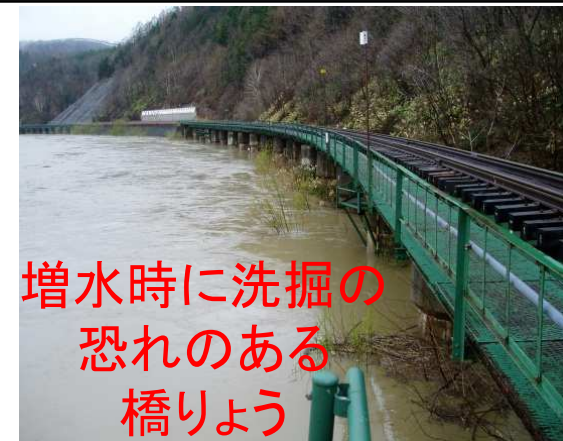
(例: 宗谷線 糠南・雄信内間 問平陸橋)
