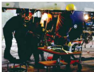
重要機器の取替
