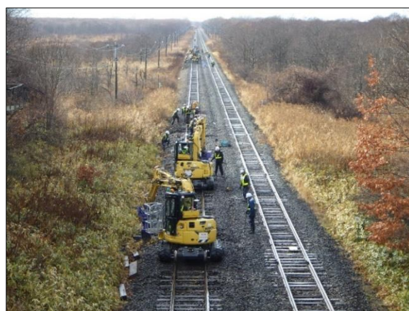
写真4. 室蘭線 沼ノ端駅～遠浅駅 間
