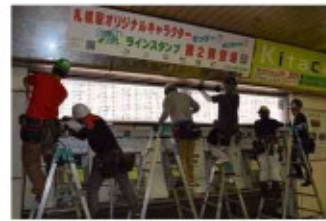
▲運賃改定に伴う料金表貼替作業の様子
