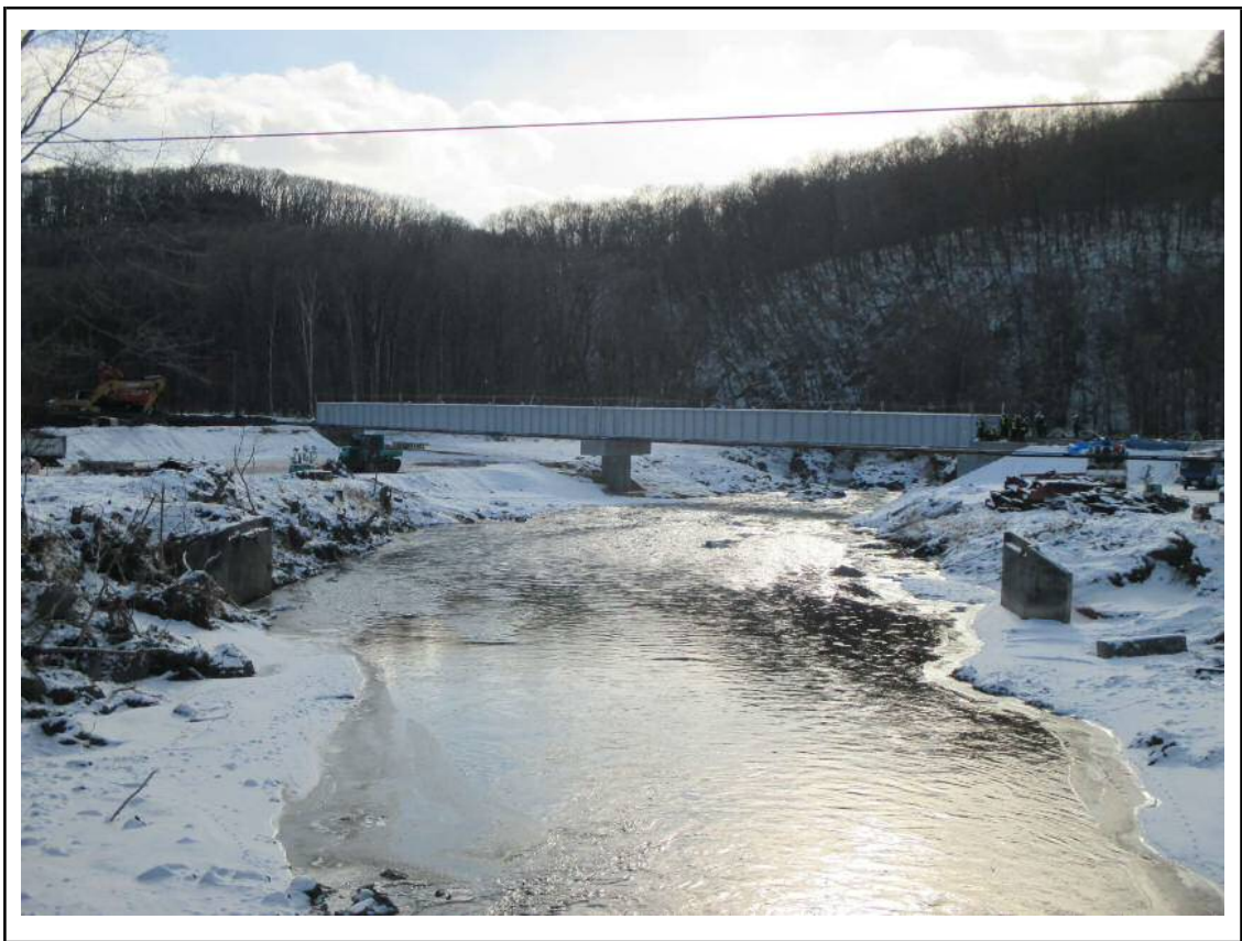
第1佐幌川橋りょう
