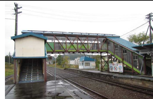
軟弱地盤上の乗換跨線橋
