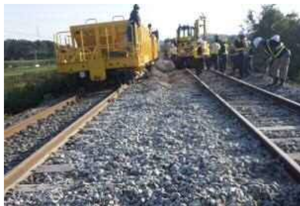
室蘭線 追分～三川間 線路復旧作業
