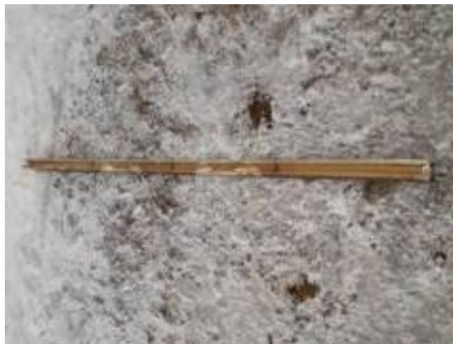
写真 1 落下した部材
