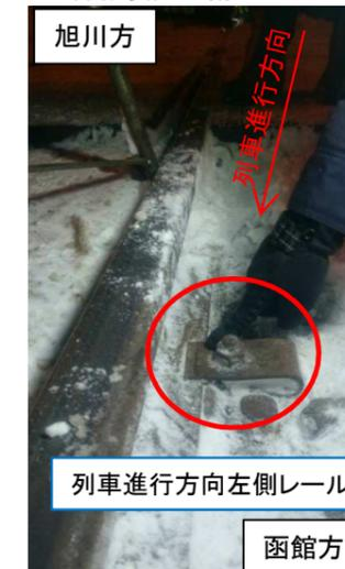
③ 銭函西部踏切～P12口間 締結装置の損傷
