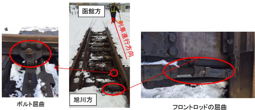
④ P12口 前端 絶縁継目部のボルト損傷
