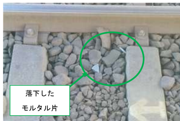
写真 2 落下したモルタル片
