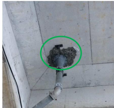
写真2 コンクリート片およびボルト落下箇所(拡大)
