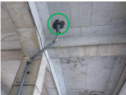
写真1 コンクリート片およびボルト落下箇所(全景)
