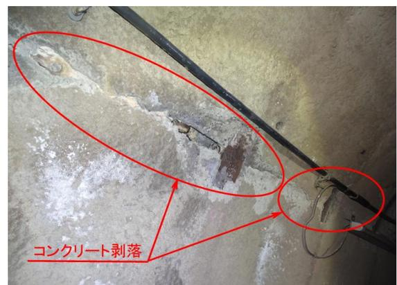
写真-2 コンクリート剥落箇所
