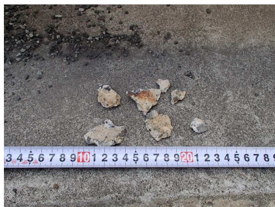
【写真 2 剥落したコンクリート片】
