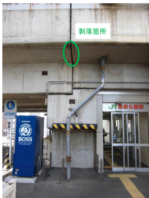
【写真 1 剥落箇所全景】
