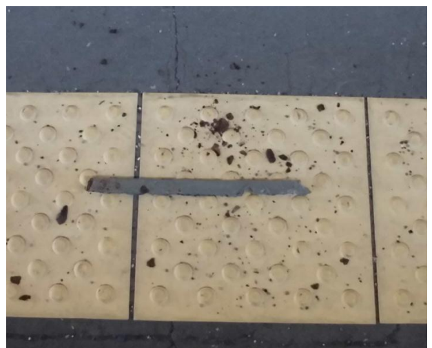
落下した鉄片
