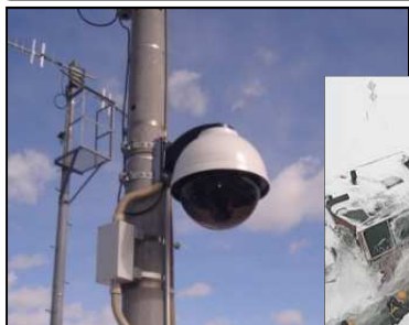
▲降雪モニターカメラの設置及びカメラ映像
