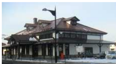
⑪旧室蘭駅舎
