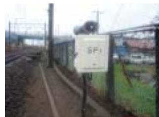
列車接近警報装置(固定式)
