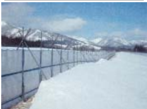
茶志内駅 - 奈井江駅間に設置している防雪柵
