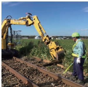
マクラギ交換作業 (釧網線 清里町駅～中斜里駅間)
