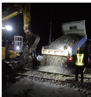
道床バラスト交換作業(室蘭線 稀府駅)
