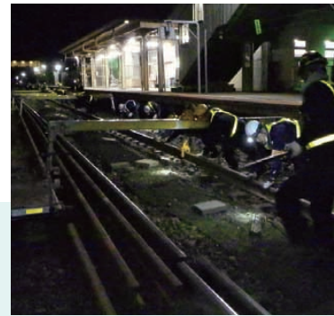
レール交換作業の様子
