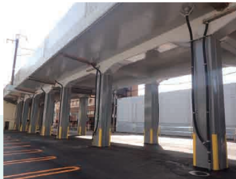
鋼板巻き補強工法により耐震化を図った高架橋(下野幌)。
