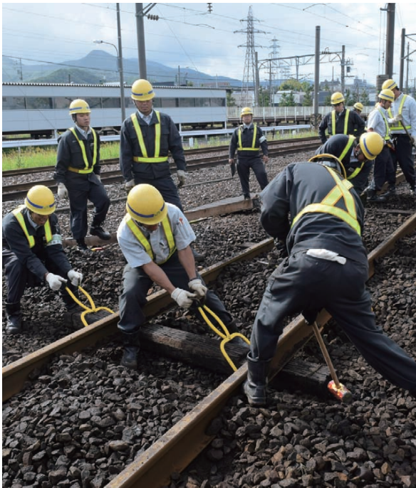
マクラギ交換の作業手順などを確認
