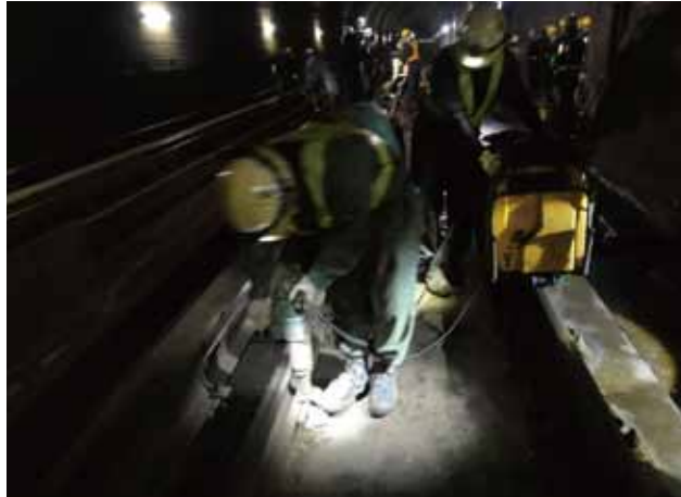
レール締結装置の交換作業。限られた時間の中で手早く行います。
