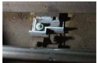
在来線専用レールと新幹線専用レール。それぞれのレール締結装置の間隔は最も狭い部分で約4cm。ここに改良型絶縁板を設置しています。
