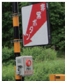
万が一のとき、列車の運転士に異常を知らせる踏切の非常ボタン。
