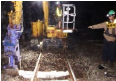
PCマクラギ化工事(根室線)
