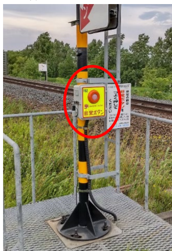
ピクトグラムを表記した踏切非常ボタン(踏切支障報知装置)
