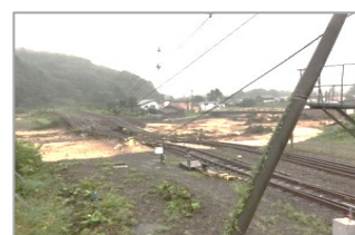
根室線新得駅構内 橋りょう流失（2016 年 8 月）
