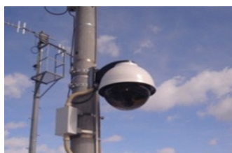
降雪モニターカメラの設置
