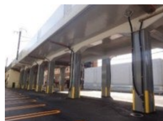
高架橋耐震補強（新札幌）
