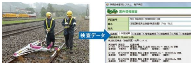
新型トラックマスターによる検測
