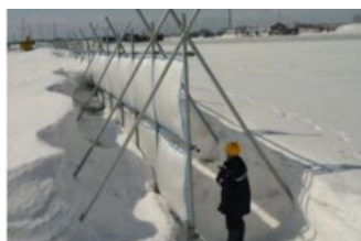
防雪柵の設置
