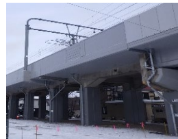
剥落防止材の作業
