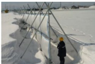
防雪柵の設置
