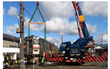
クレーンによる載線(車両持ち上げ)
