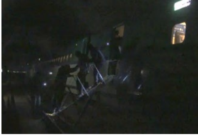
避難用渡り板の設置
