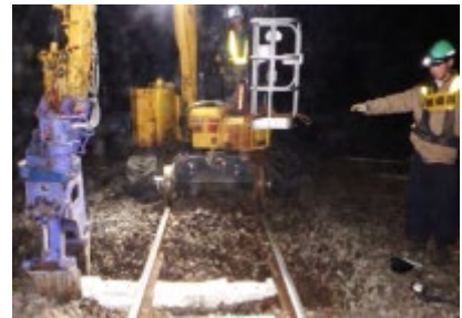
PC マクラギ化工事 (根室線)
