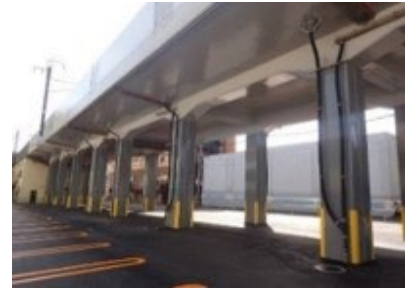
高架橋耐震補強（新札幌）
