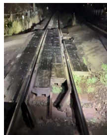
踏切全景（下り線）
