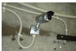
陸底部斜坑のカメラと放送設備
