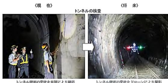
トンネル壁面の変状を目視により確認
