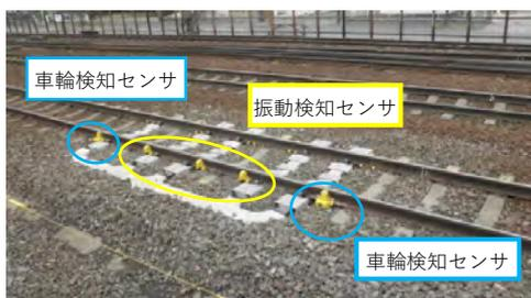
車輪検知センサ・振動検知センサ
