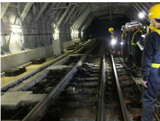
第 11 回 JR 北海道再生推進会議（平成 29 年 5 月 24 日） 木古内駅構内三線分岐器機能検査の現地調査
