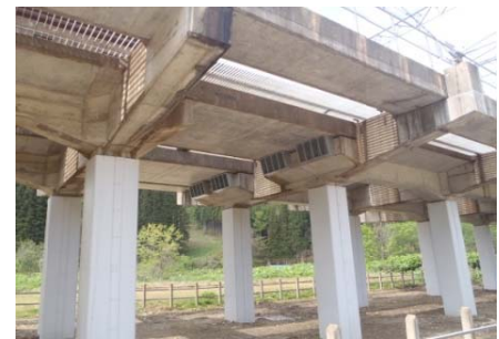
RCラーメン高架橋柱の鋼板巻き補強
