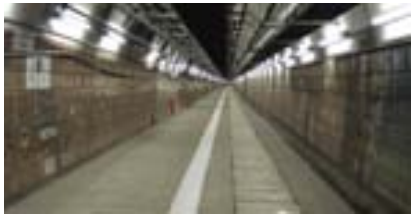
吉岡定点下り線誘導路のトンネル床誘導線
