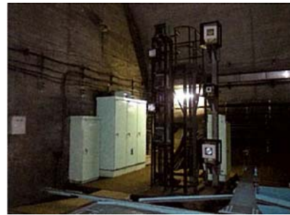
列車火災検知装置
