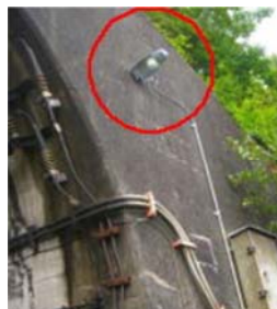
トンネル出入口の照明
