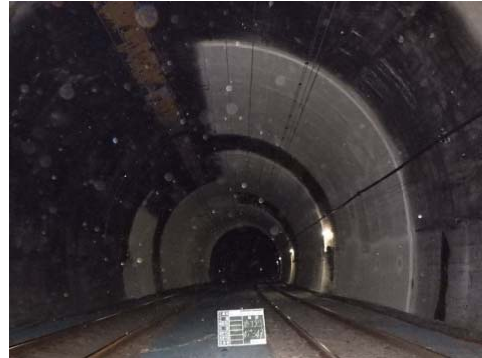
断熱防水板設置後の状況
