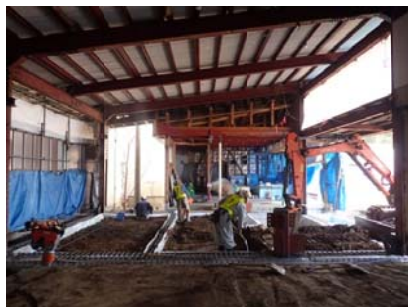
基礎工事状況
