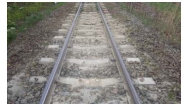
渡島砂原駅～掛瀬駅間の線路状態
