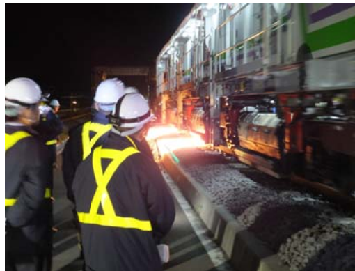
第 11 回 JR 北海道再生推進会議（平成 29 年 5 月 24 日） 木古内新幹線保守基地におけるレール削正作業の現地調査
