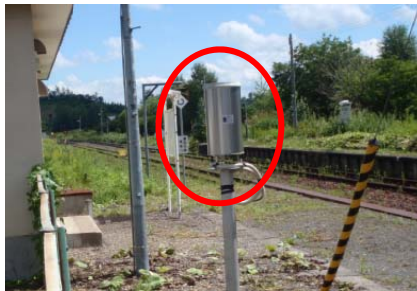
雨量計の増設
