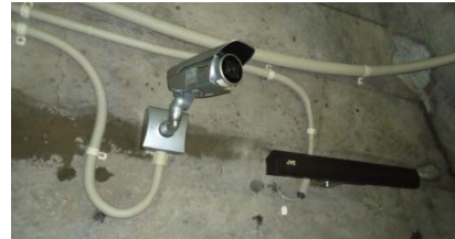
陸底部斜坑のカメラと放送設備
