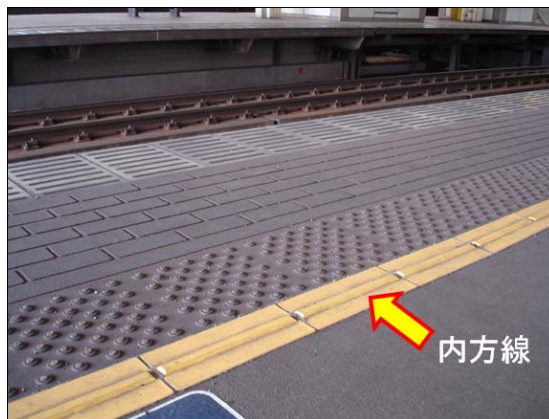
内方線の整備
