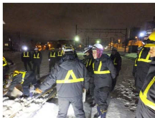
厳冬期駅構内除雪作業現地調査（手稲駅）
