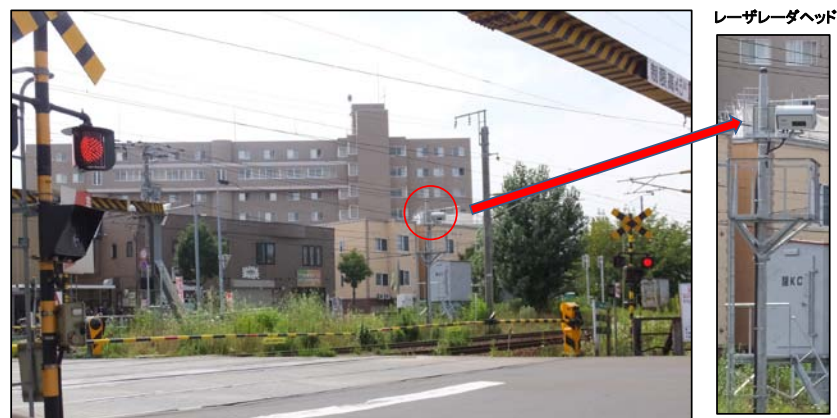
三次元レーザーダ式障害物検知装置 (函館線 発寒駅～発寒中央駅間)
