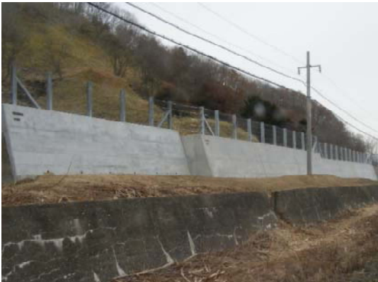
(落石止擁壁 (根室線 白糠駅～西庶路駅間) )
