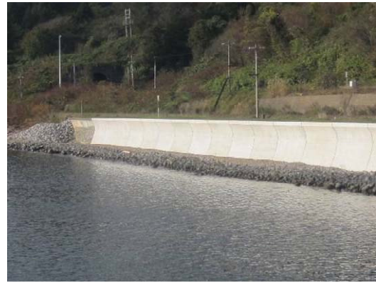
(護岸 (室蘭線 豊浦駅～洞爺駅間) )
