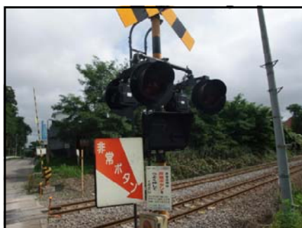
(踏切支障報知装置)
