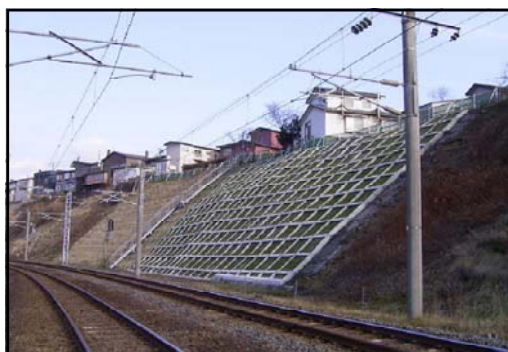
(のり面格子砕工)
