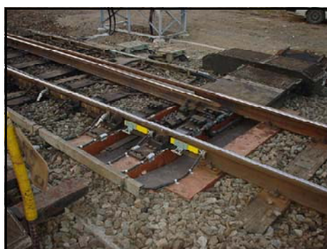
(圧縮空気式分岐器除雪装置)
