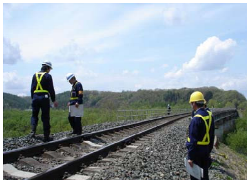
(現地における安全診断) ・保線機械作業事前調査状況
