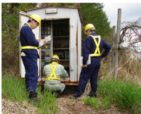
(現地における安全診断) ・踏切の動作確認点検状況
