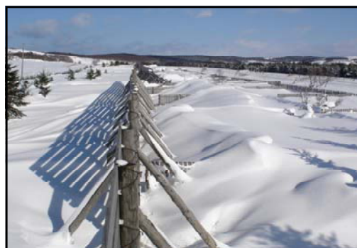
(防雪柵の設置)
