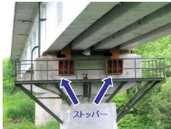
「落橋防止工」(ストッパー)
