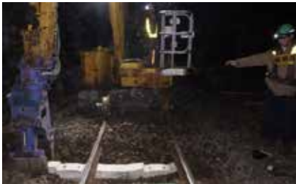
PC マクラギ化工事（根室線）
