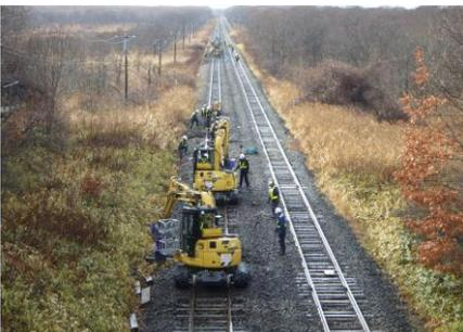
鉄道施設を維持するために11月9日～13日、追分駅～沼ノ端間で一部列車を運休し、線路集中メンテナンスを実施しました。約2,000本の木製マクラギを交換して線路の状態を改善しました。
