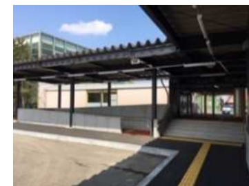
北海道医療大学駅 (スロープ新設)
