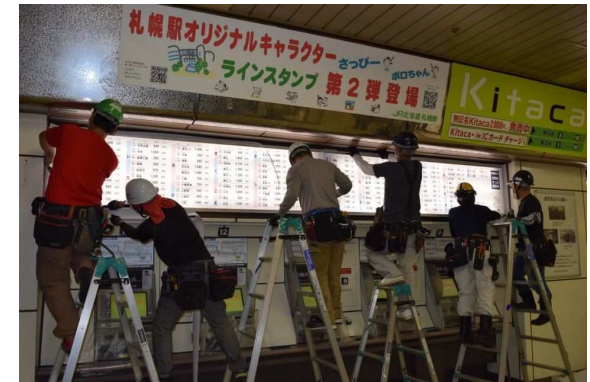
▲運賃改定に伴う料金表貼替作業の様子
