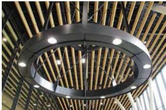
新函館北斗駅LED照明
