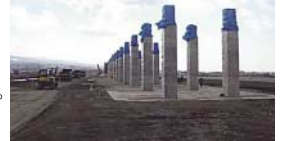
北斗市に建設されている稲里高架橋。
