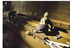
青函トンネル内のレール敷設工事。
