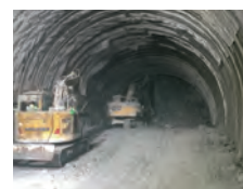
渡島トンネル(台場山) トンネル掘削工事状況 提供:鉄道・運輸機構
