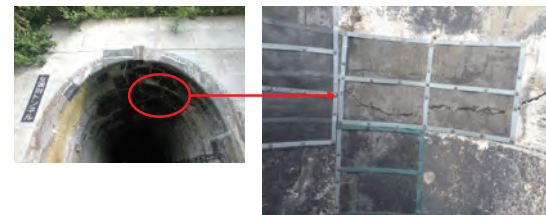
女満別トンネル[経年、地山の凍結による変状] ○経年113年(1912年完成) ○石北線 女満別～呼人 間
