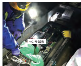
転つ機用センサ等設置施工
