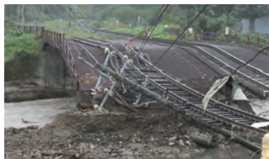
根室線新得駅構内 橋りょう流失(2016年8月)
