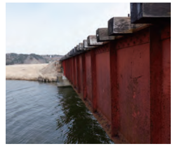
第6尾幌川橋りょう[経年] ○経年106年(1919年完成) ○根室線 厚岸～茶内 間
