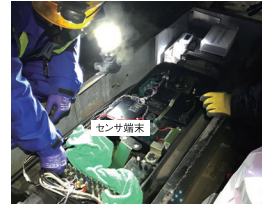
転てつ機用センサ等設置施工
