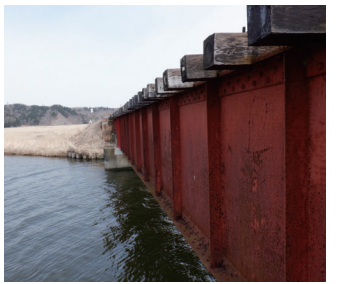
第6尾幌川橋りょう[経年] ○経年105年(1919(大正8)年完成) ○根室線 厚岸～茶内 間
