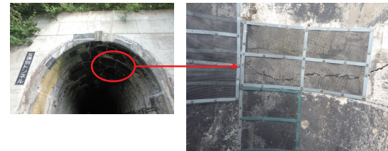
女満別トンネル[経年、地山の凍結による変状] ○経年112年(1912(大正元)年完成) ○石北線 女満別～呼人 間
