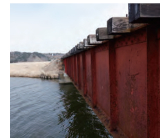
第6尾幌川橋りょう[経年] ○経年107年(1919年完成) ○根室線 厚岸～茶内 間
