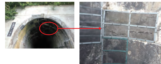
女満別トンネル[経年、地山の凍結による変状] ○経年114年(1912年完成) ○石北線 女満別～呼人 間
