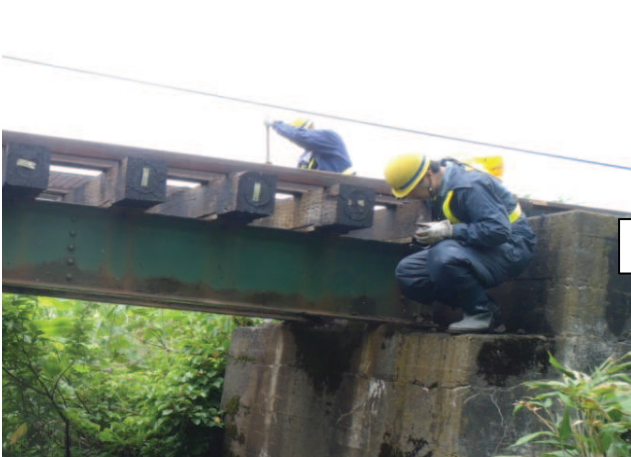
橋りょうの変状を目視により確認
