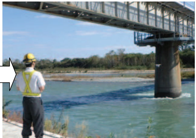
橋りょうの変状をドローンにより撮影
