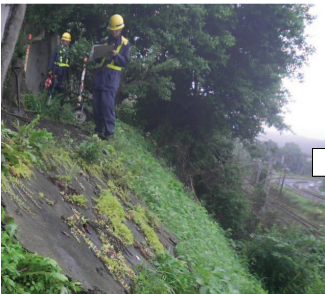
斜面の変状を目視により確認
