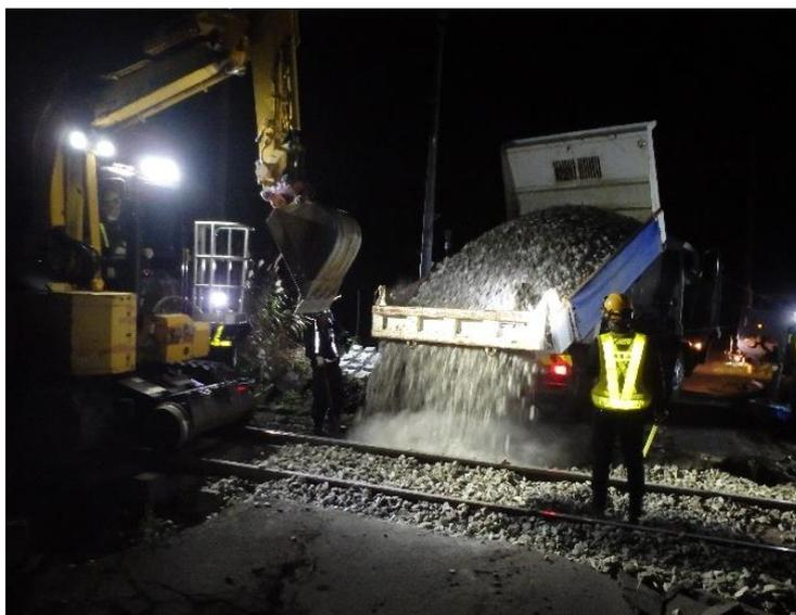
写真2. 道床バラスト交換作業（稀府駅）
